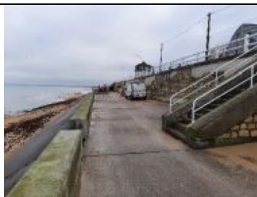
Réfection de digues entre Ouistreham et Lion sur Mer
