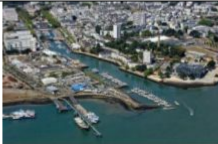
Travaux d'infrastructure dans les différents ports de Lorient
