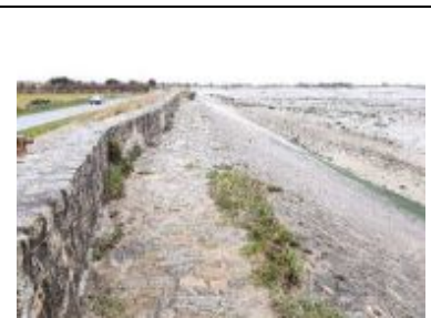
Réfection de digues à Saint-Vaast la Hougue
