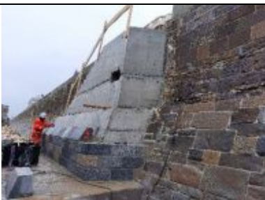
Réfection de digues à Saint-Malo
