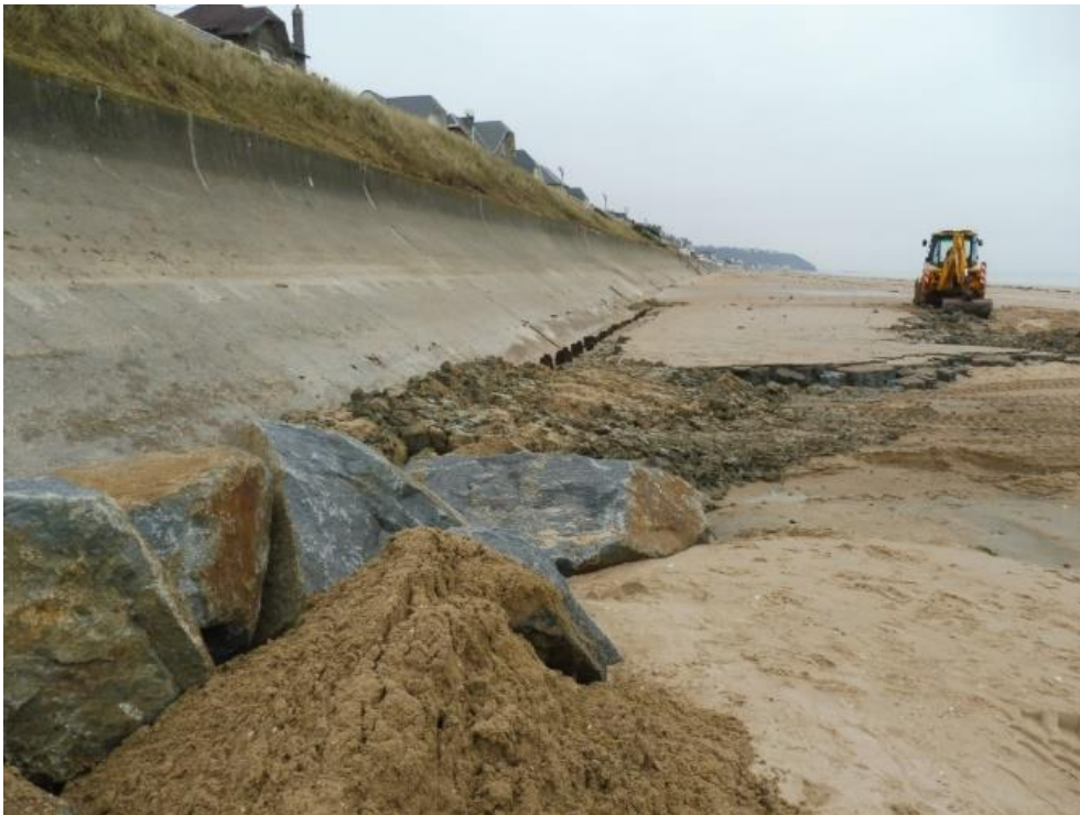
Figure 2-10 : Travaux de recharge en 2018 [5]
