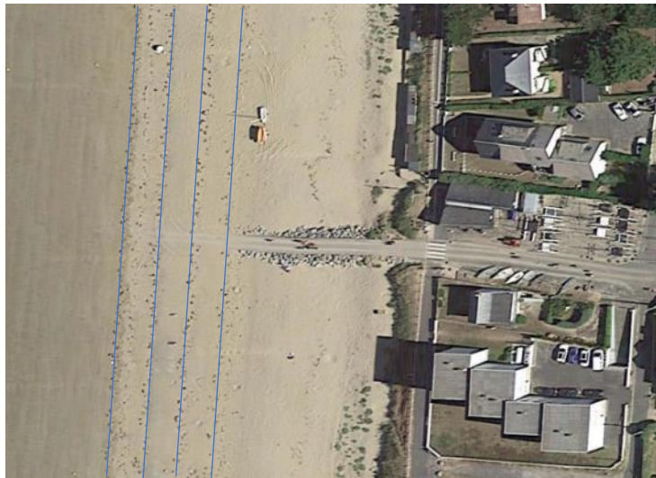
Figure 3-13 : Cale d'accès et absence de dérive littorale : en bleu, les lignes de dépôts (Source : Google Earth)
