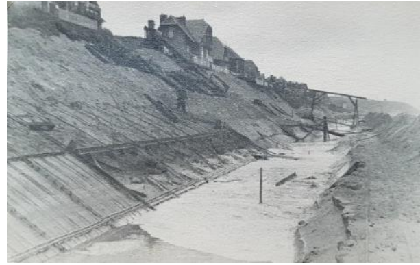
Figure 2-3 : Construction du perré [4]
