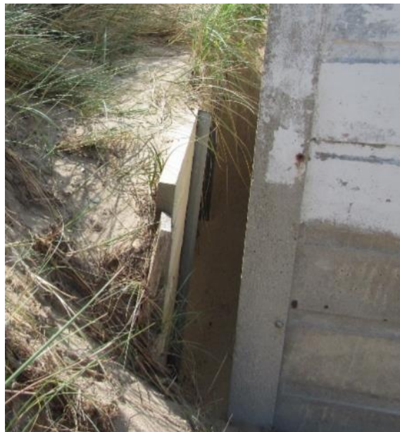
Figure 6-6 : Structure en pieux planches relevée lors de la visite (Source : photo ISL)
