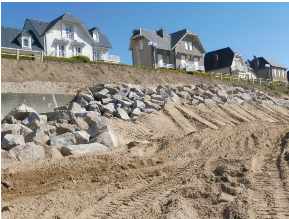
Figure 2-12 : Fin des travaux de 2020 [5]
